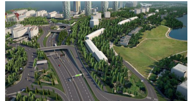
TUNNELIT JA VÄYLÄT: Keilaniemi ja Kehä I:n alku
