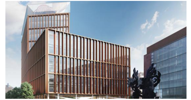
UUDISRAKENTAMINEN: We Land -toimistotalo, Helsinki
