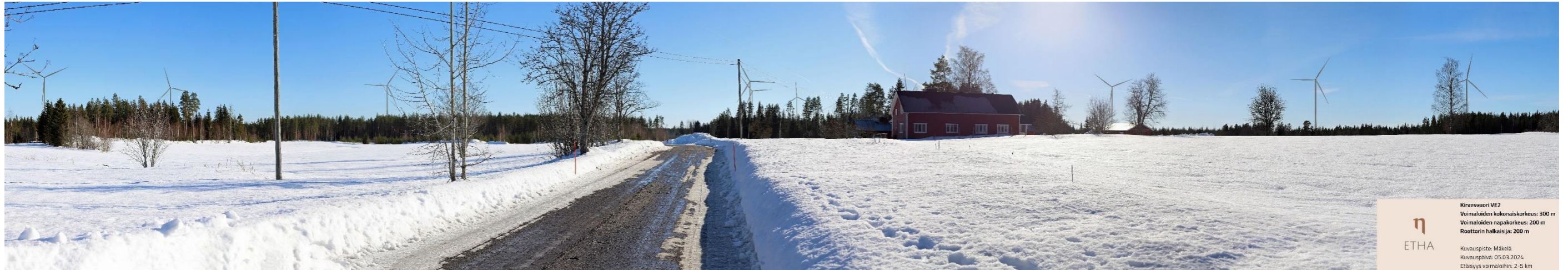
Kuva 2.4. Vaihtoehdon VE2 havainnekuva Mäkelän kyläalueelta Mäkeläntieltä. Etäisyys kuvauspisteestä voimaloihin on noin 2–5 kilometriä.
